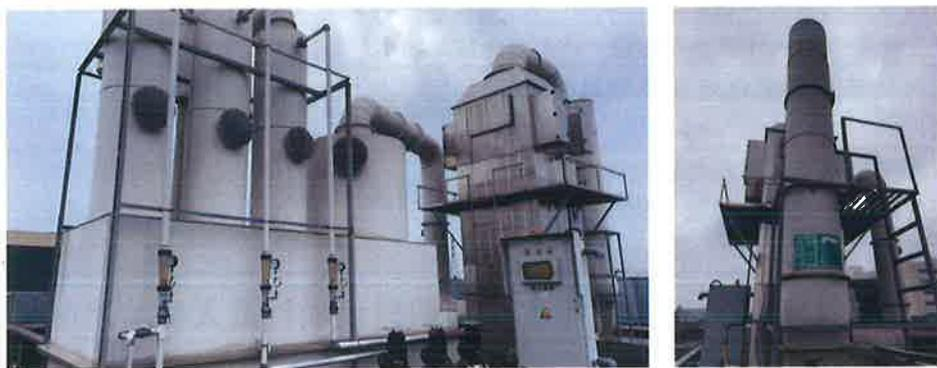
图 4-1 工艺废气处理设施现场图
