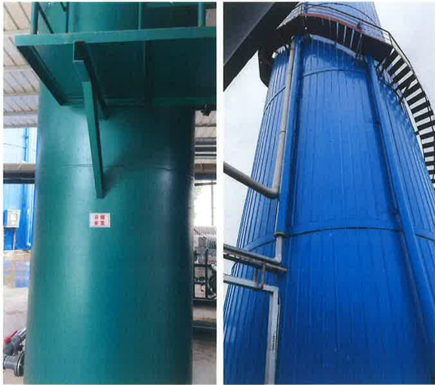
图 4-4 污水站现场图
