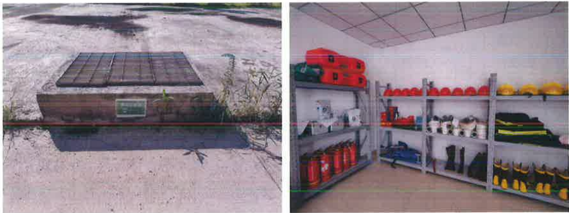
图 4-7 事故应急池与应急物资现场图
