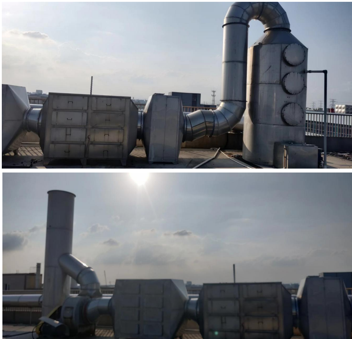
图 4-3 混合、搅拌、复配、灌装废气处理设施
