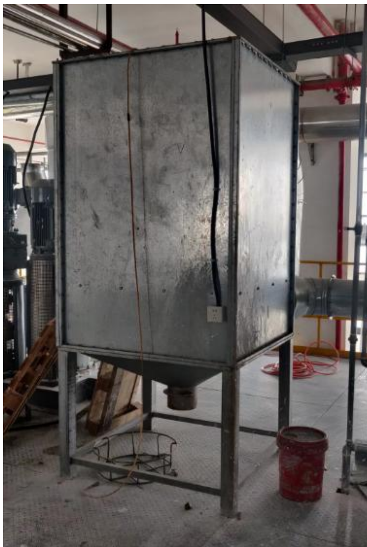
图 4-2 投料废气处理设施
