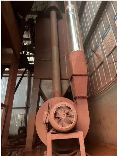
喷雾干燥废气处理设施图（设备自带除尘布袋）
