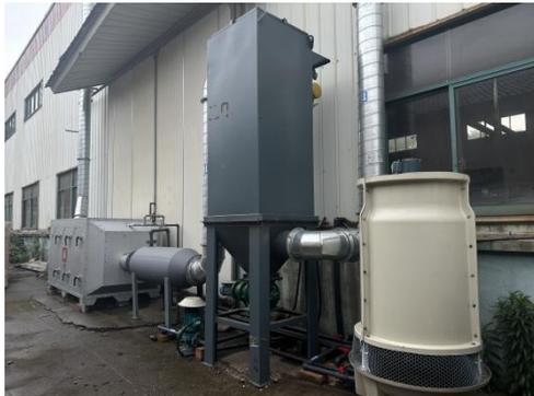
烧结废气废气处理设施图（高温除尘布袋+水冷+活性炭吸附）
