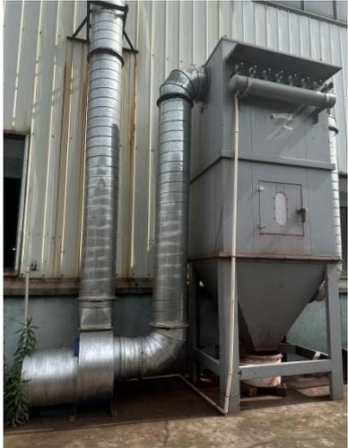
粉尘废气处理设施图（布袋除尘器）
