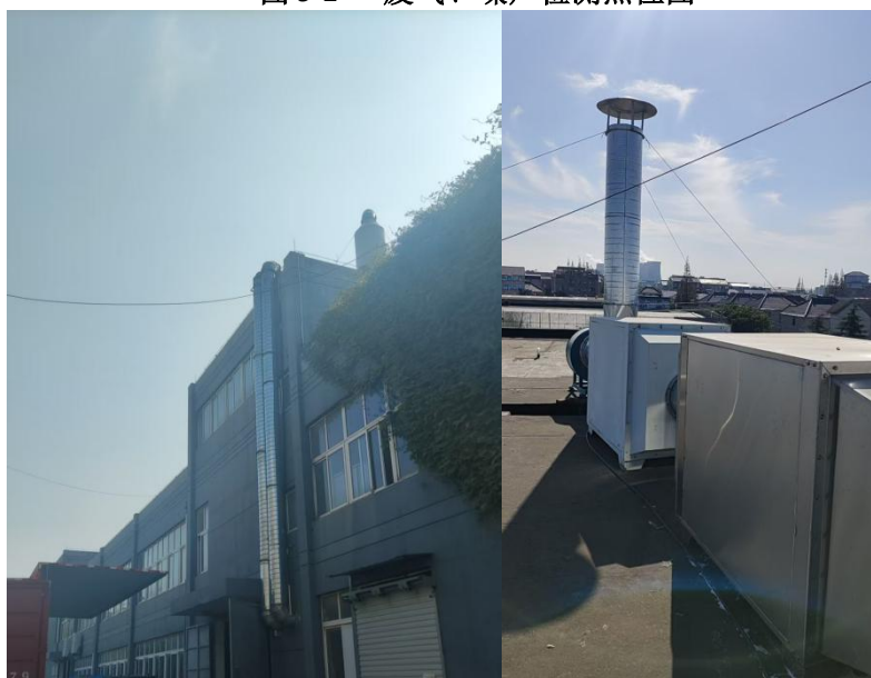
图 3-3 干式过滤+活性炭吸附处理装置
