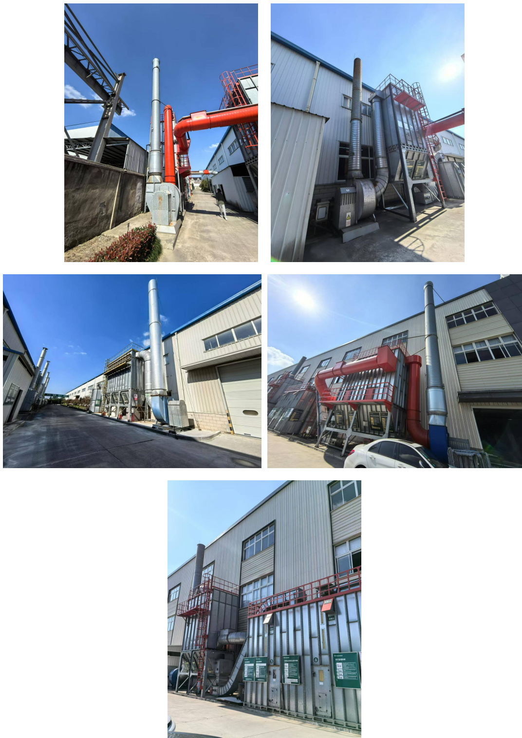
图 4-1 布袋除尘器现场图 (DA001~DA009)
