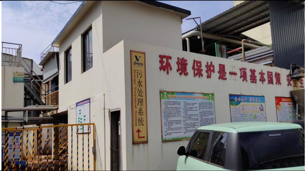
污水处理系统
