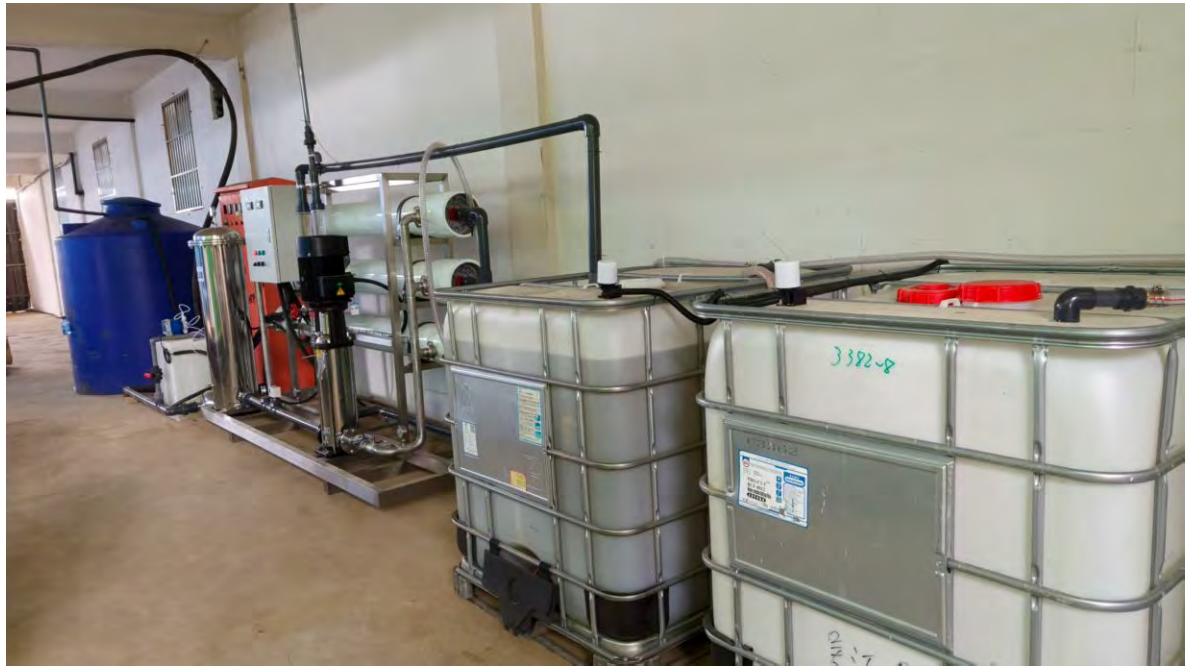
图 4.1-2 反渗透装置工艺图及实际设备图
