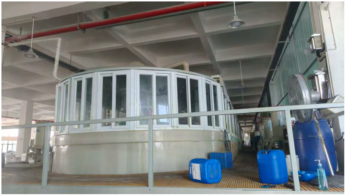
密闭的镀镍铬生产线
