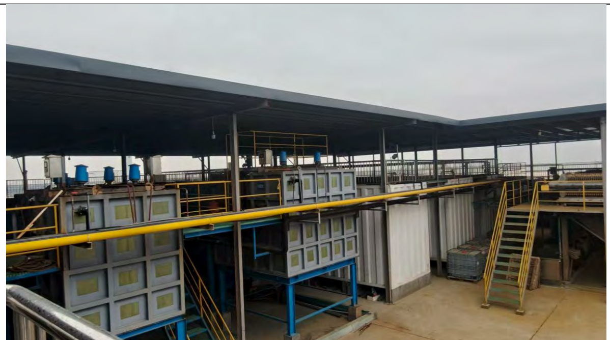
架空的楼顶污水站
