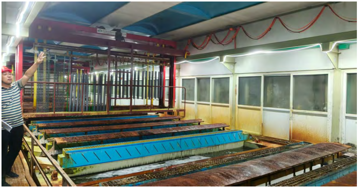
密闭镀锌线（内部）
