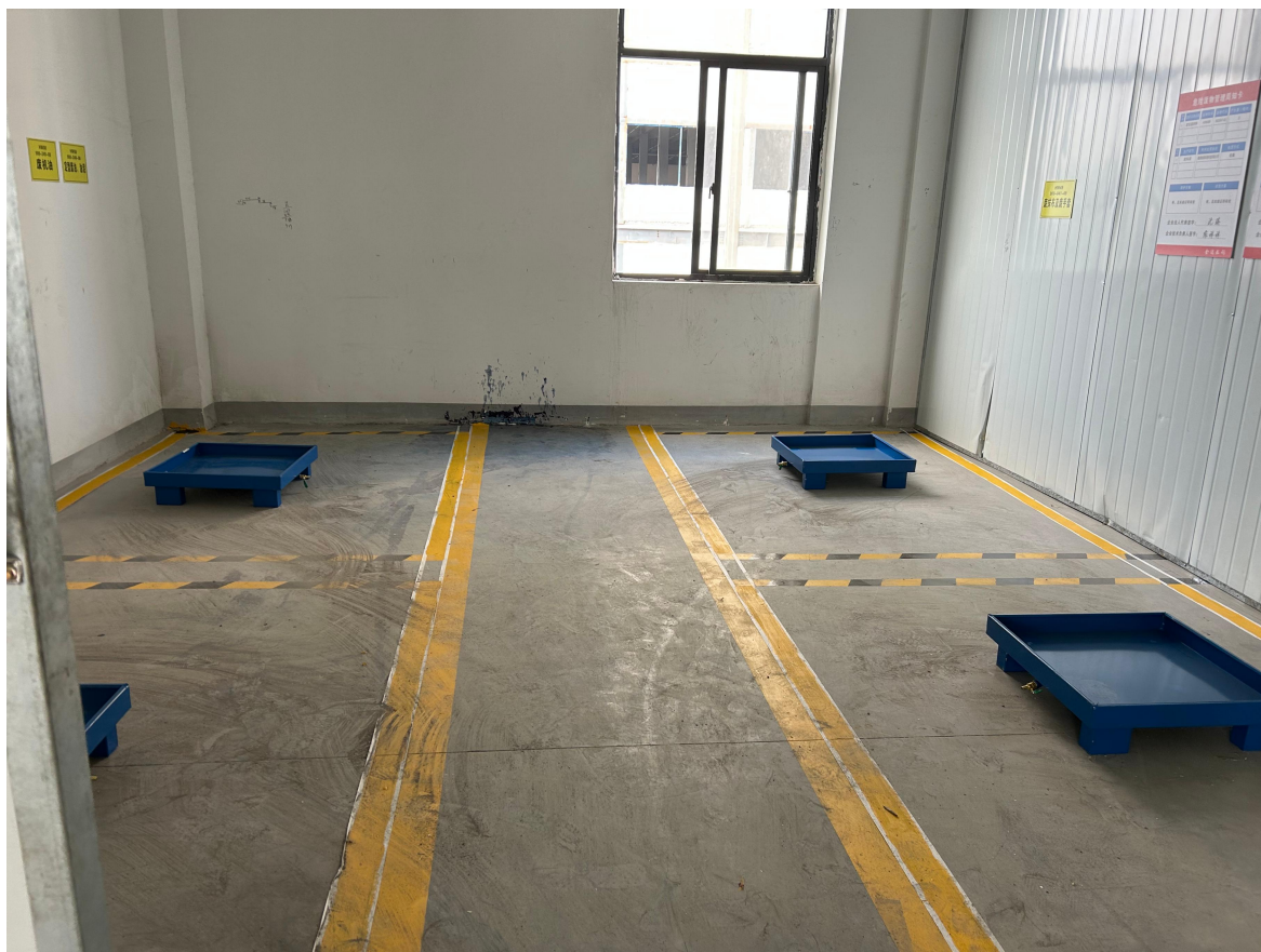
图 4-3 危废仓库现场图
