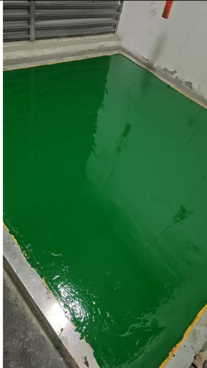
图 3-4 危废仓库现场图
