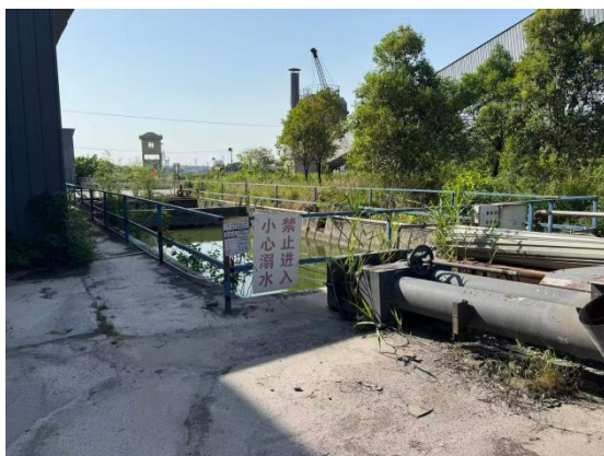
循环冷却水池
