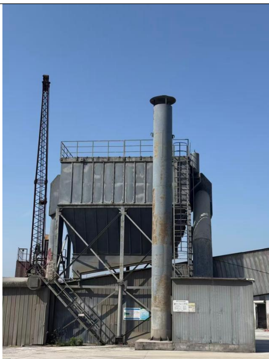
北侧吊机废气处理设施 TA015
