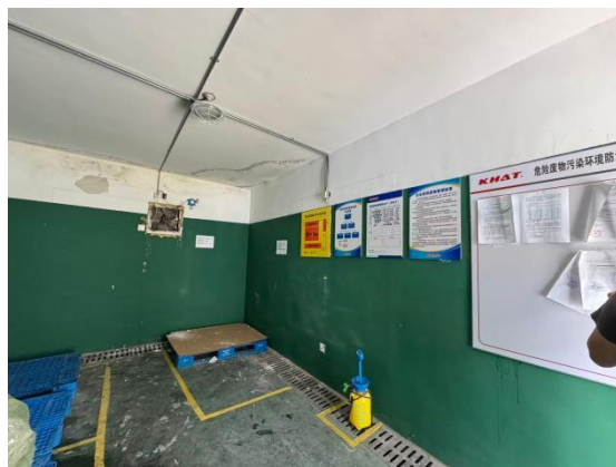
危废仓库内部 1
