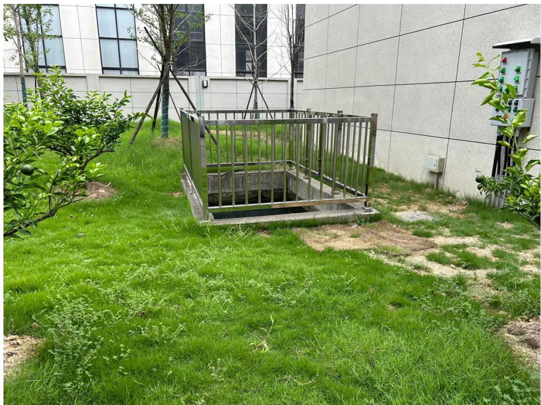
图 3-3 事故应急池现场图
