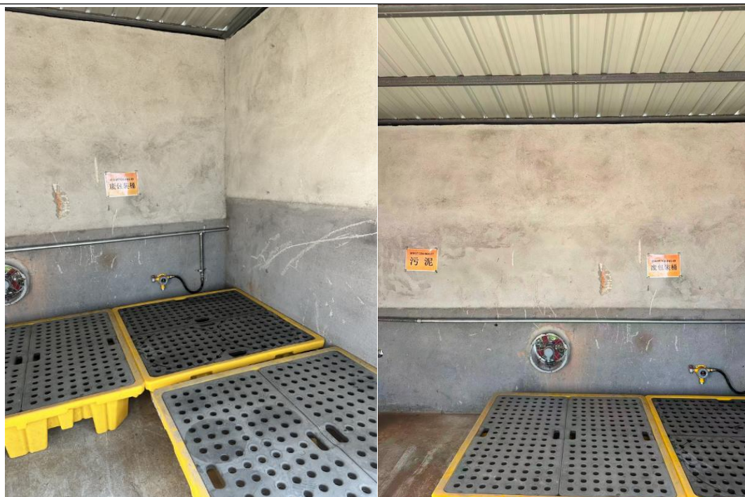
图 3-5 危废仓库现场图
